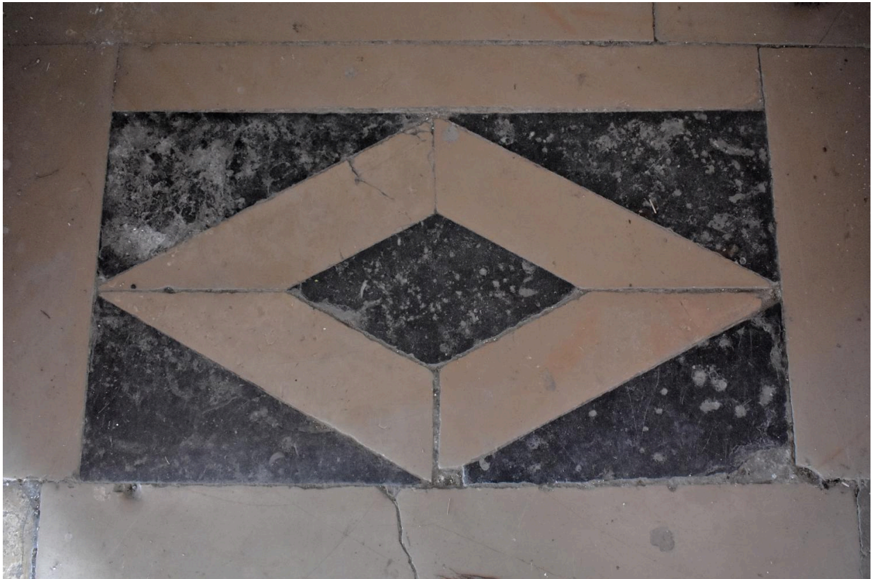
Rez-de-chaussée : détail de pavement du vestibule
