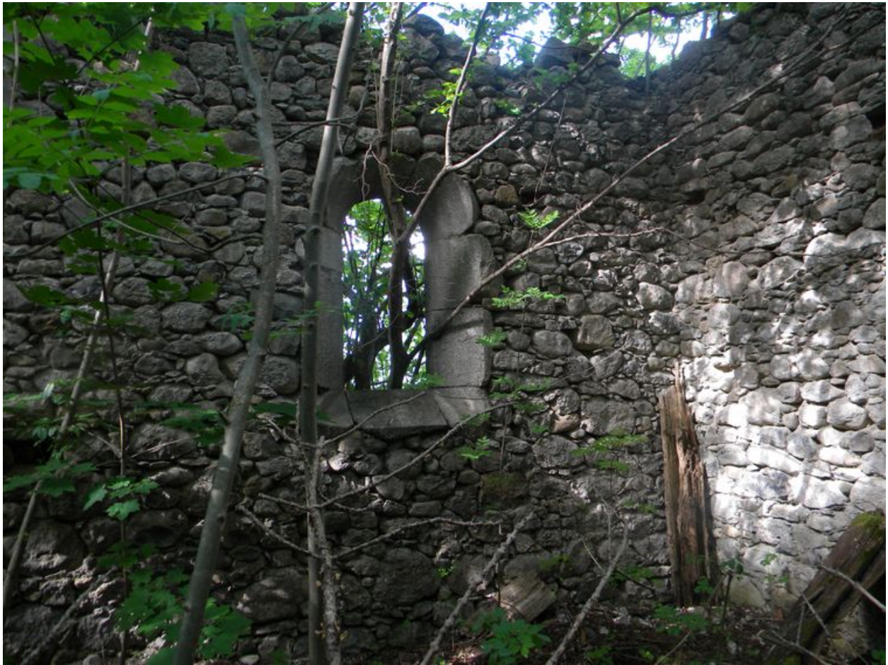
Baie sur le mur gouttereau nord
