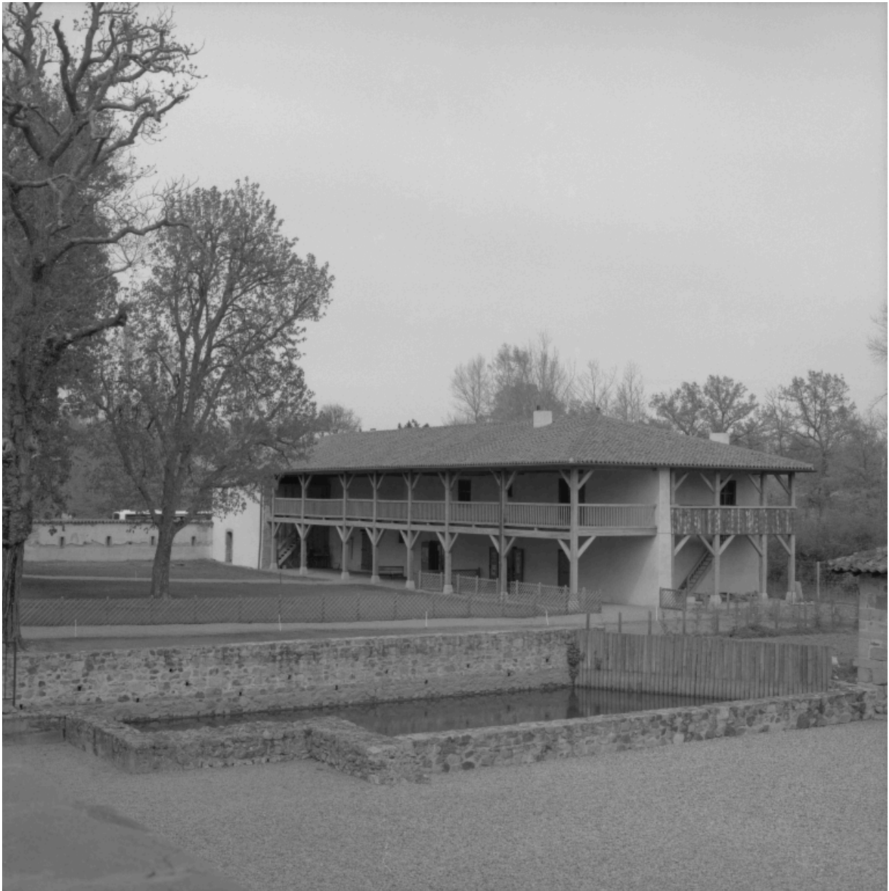
Vue générale du bâtiment est des communs, du sud-ouest.
