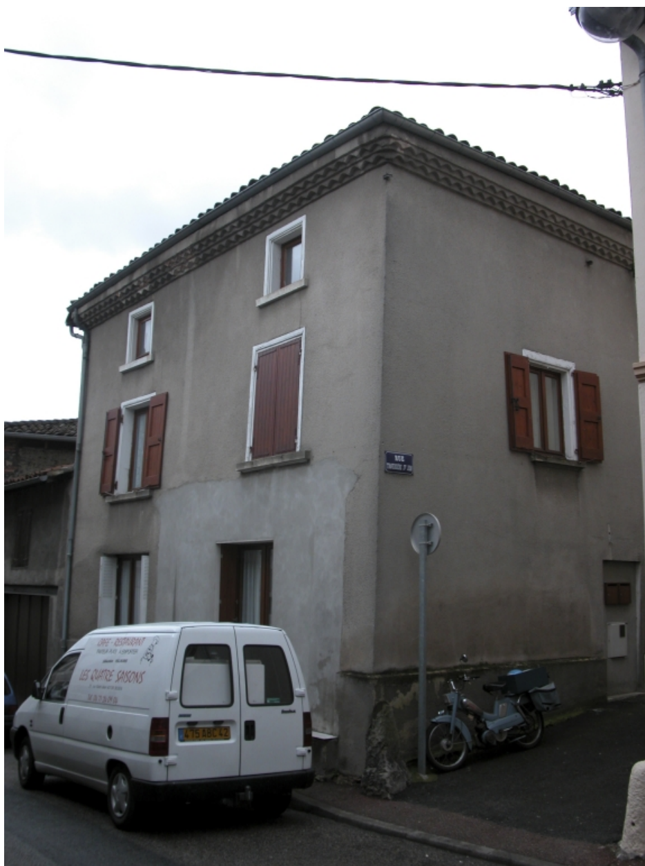
Îlot 2. Saint-Jean (rue) 38. Vue générale de la façade sur rue
