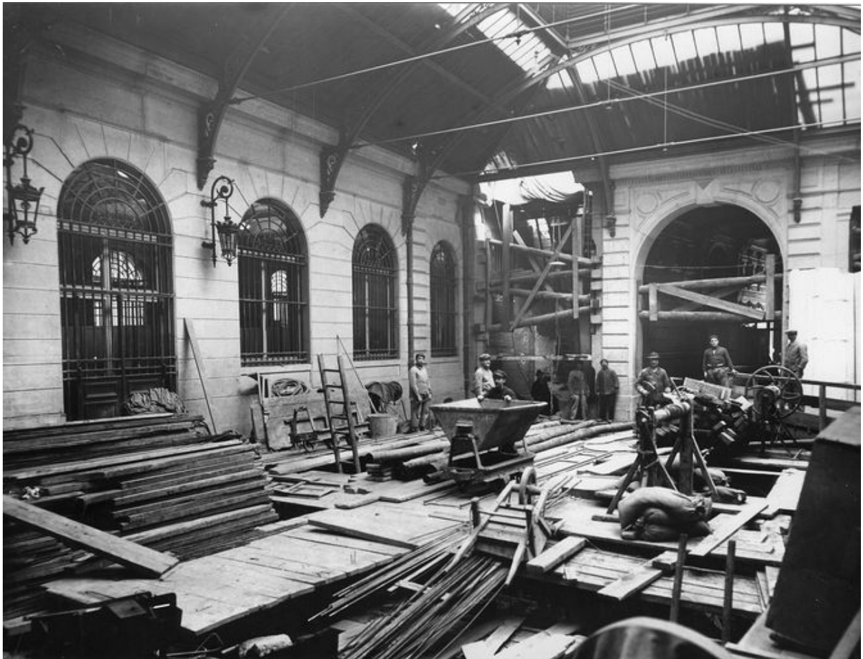
Vue du chantier d'aménagement de l'escalier des bureaux, en 1921-1922 (Banque de France, PHAR, non coté, photographie).
