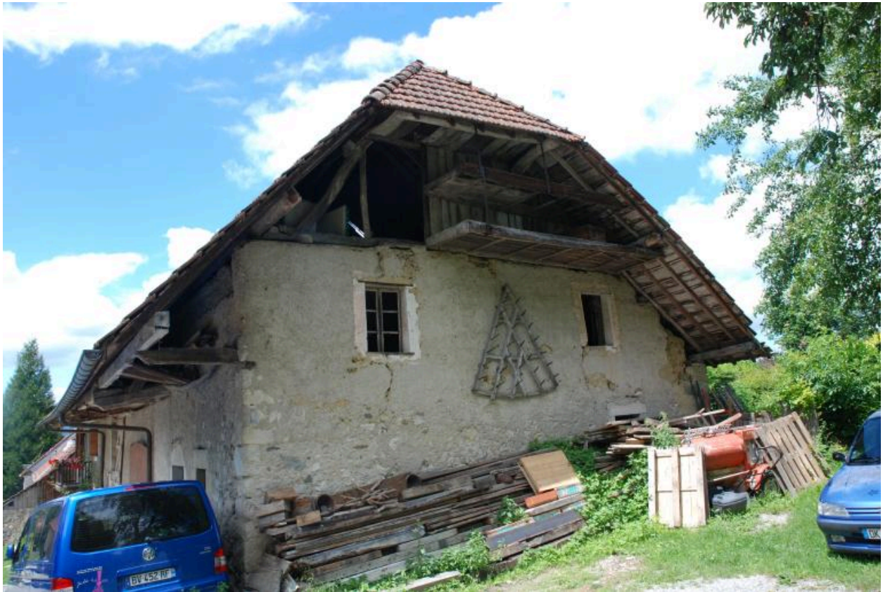
Vue du mur pignon est.
