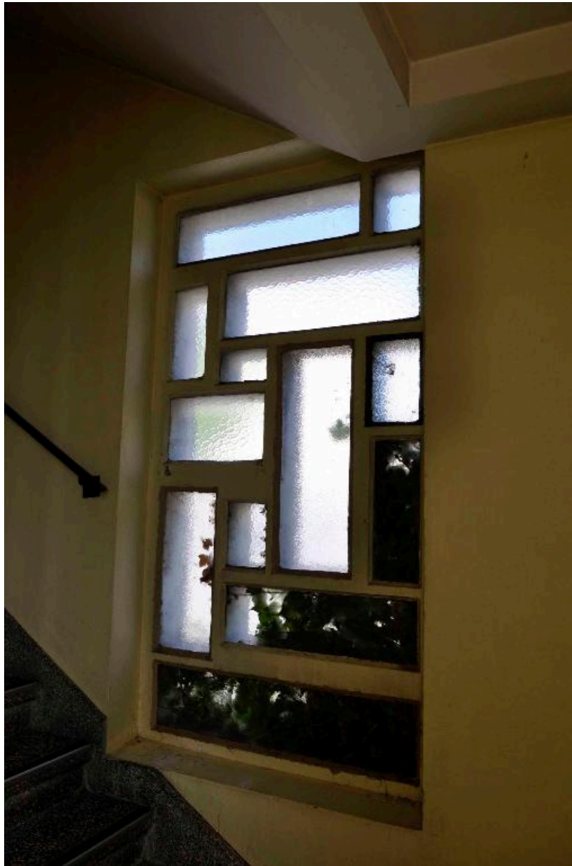
Gymnase, détail d'une baie éclairant l'escalier
