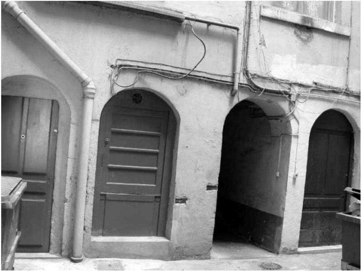
2e corps de bâtiment, élévation sur cour du rez-de-chaussée
