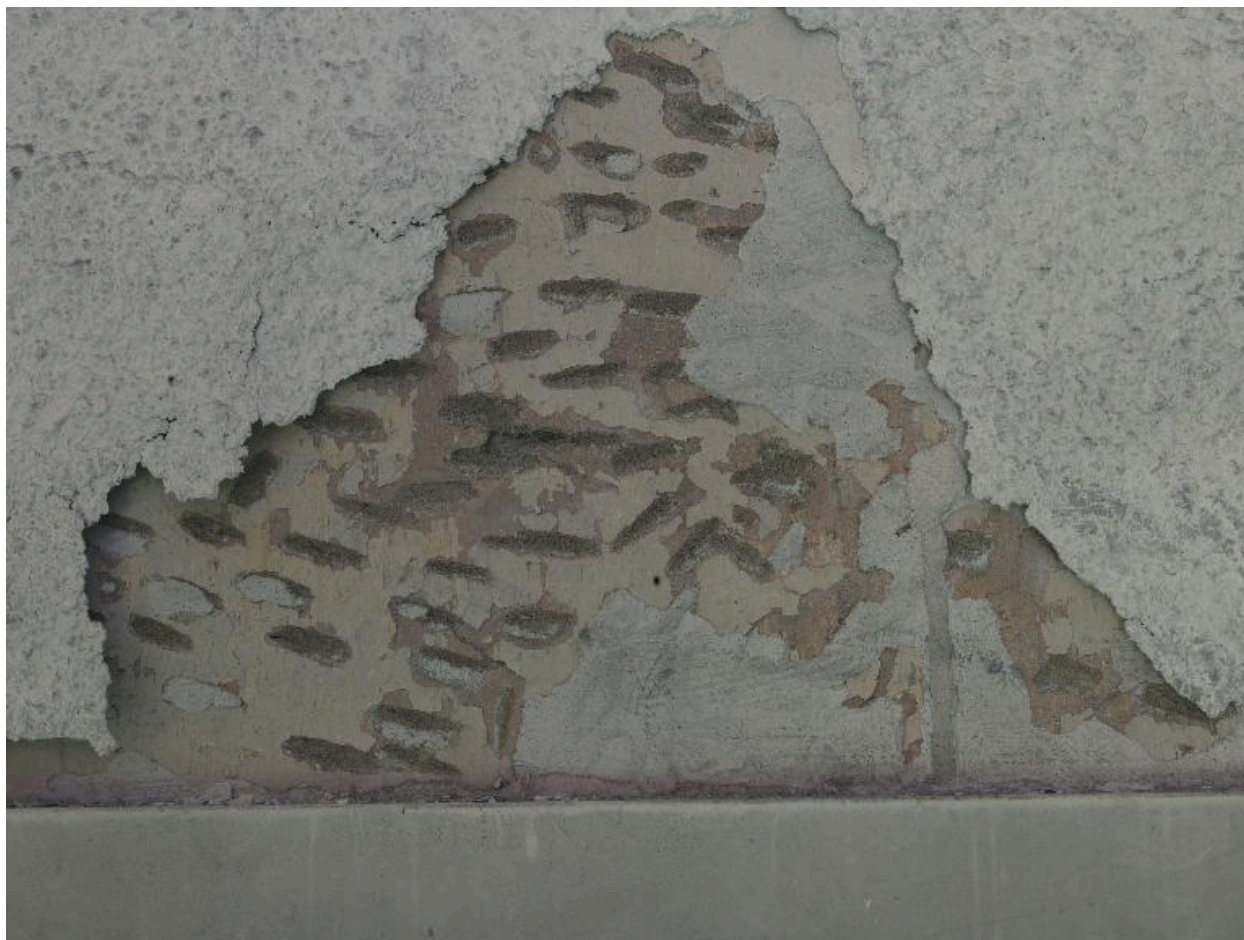
Mur sud : détail du décor d'origine bûché
