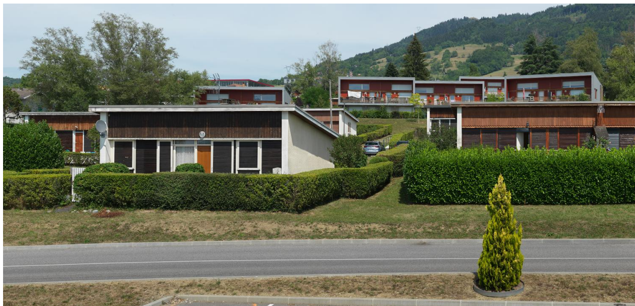
Vue sud-ouest de la cité ouvrière Lachat
