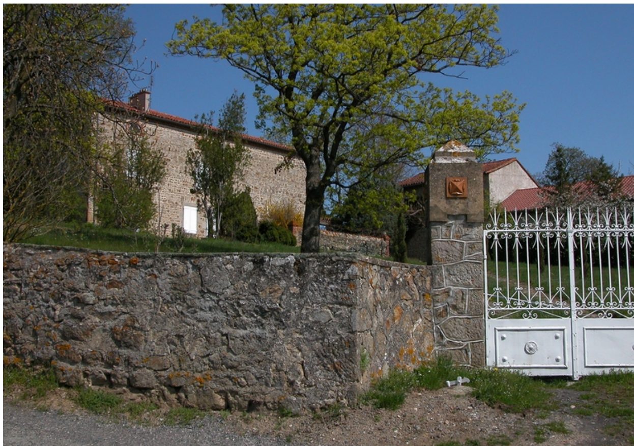
Vue générale depuis l'ouest.
