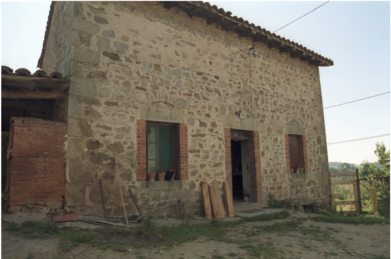
Marcoux, Bruyère (1986 B3 786), type A1. Façade antérieure du deuxième logis, en moellons.
