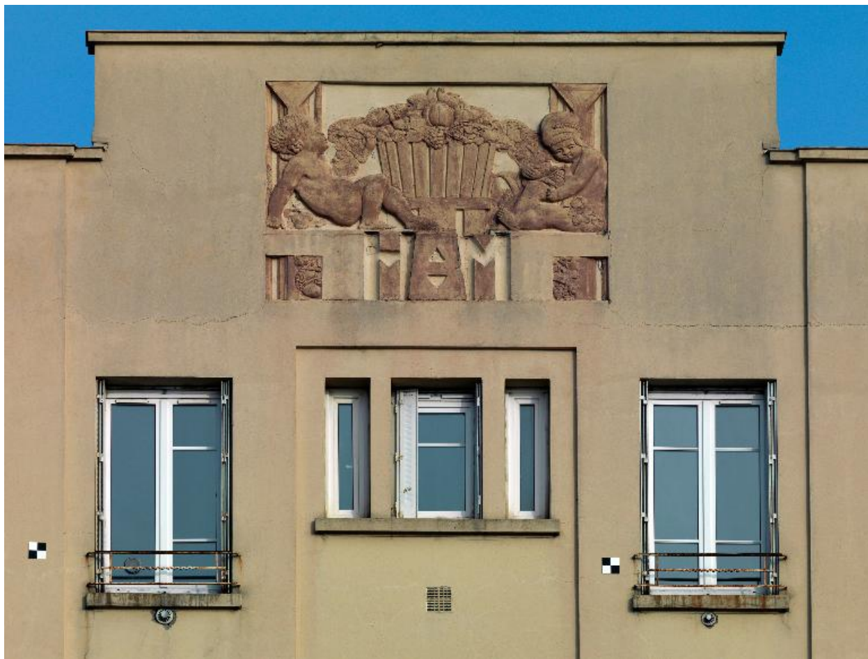
Haut-relief ornant la façade adressée 5 rue Marie-Anne-Leroudier
