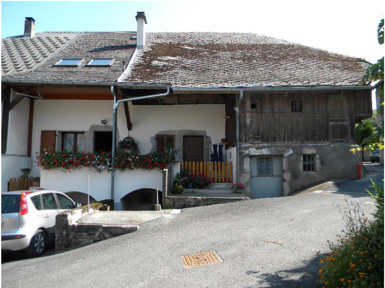
Vue d'un alignement de façade au nord-ouest.
