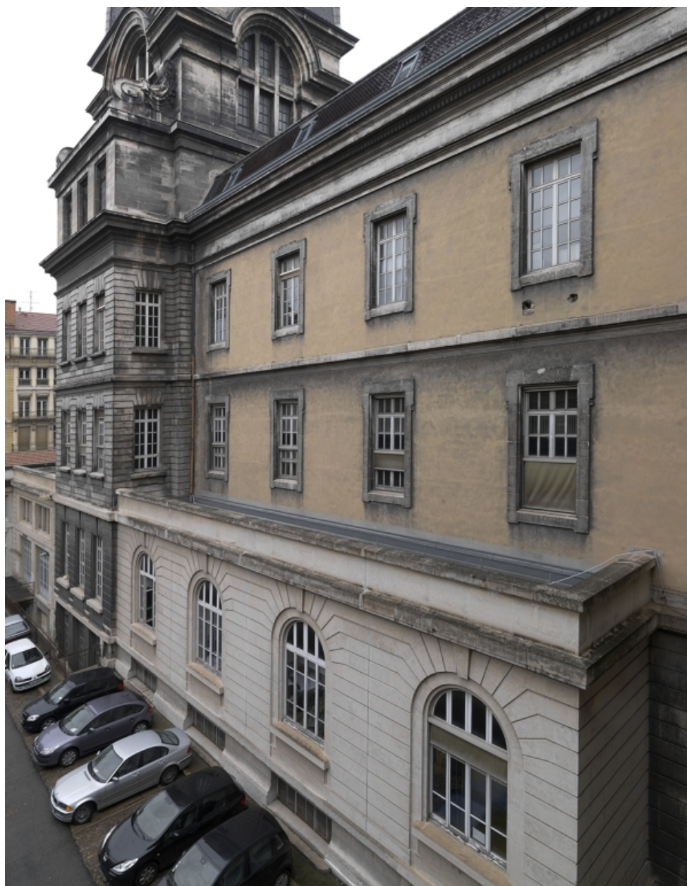
Bâtiment C. Façade sud. Le corps de bâtiment en rez-de-chaussée accolé à la façade d'origine
