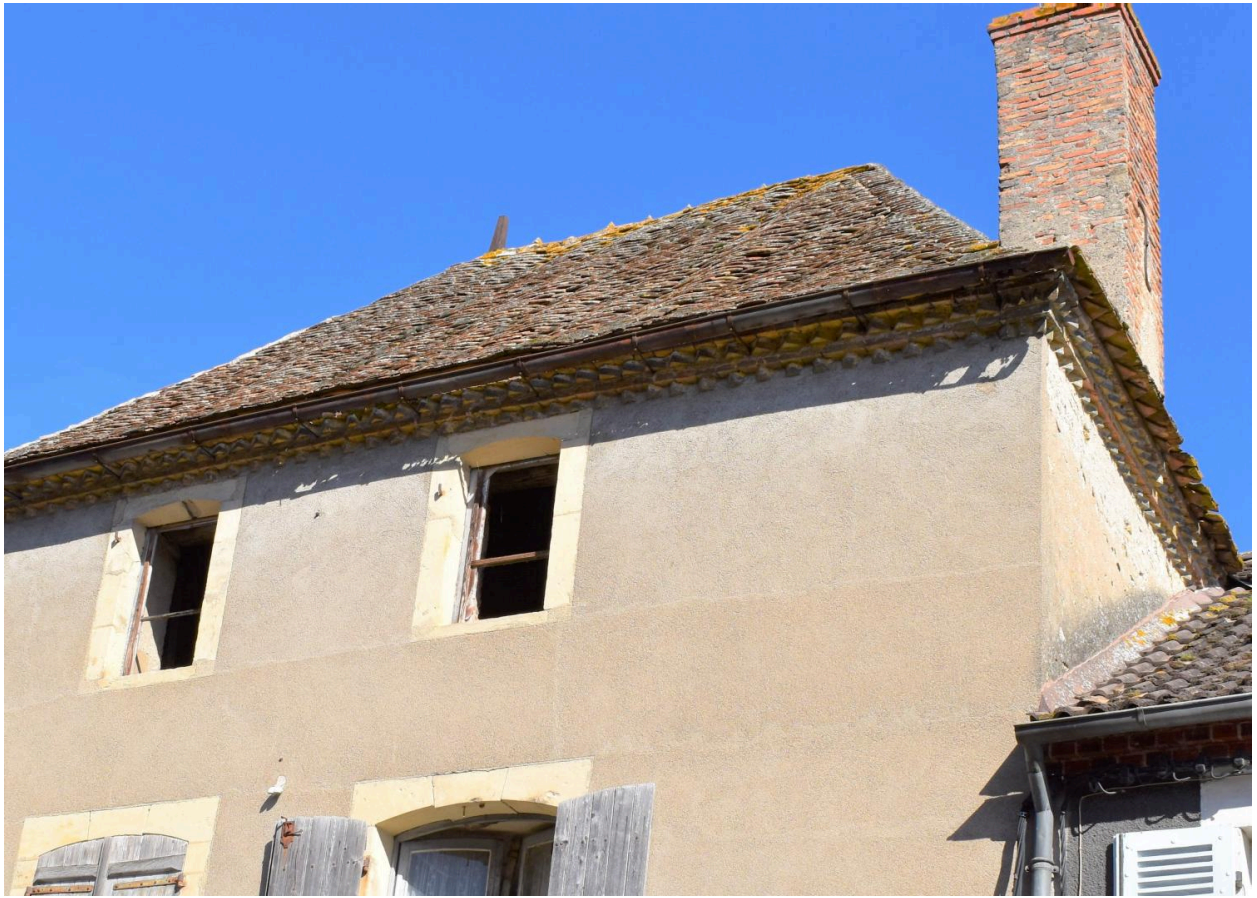
Maison dite hôtel des Vilhardin de Marcellange, 8, rue Monnet parcelle cadastrale B01 : 94. Détail de la corniche à rangs alternativement de briques en pointe et droites.
