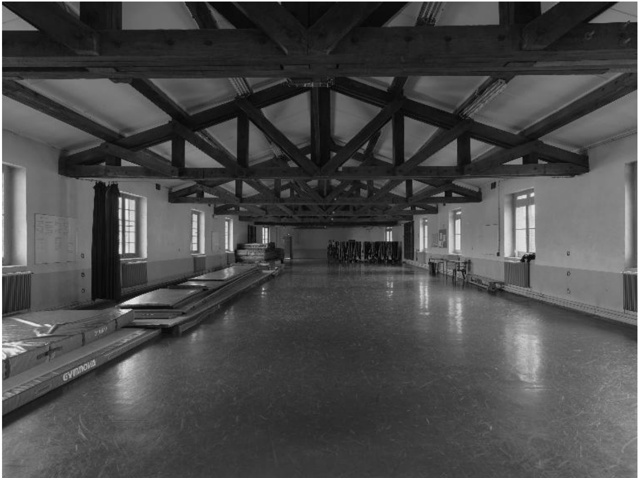
Comble, actuellement gymnase : vue d'ensemble de la 2e salle, depuis l'ouest
