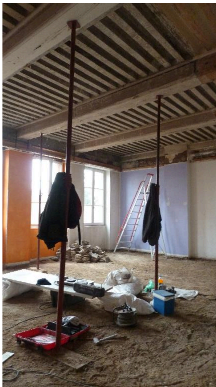
Vue d'un appartement en cours de travaux
