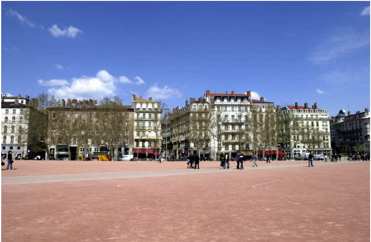
Façade nord de la place entre la rue Emile-Zola et la rue de la République
