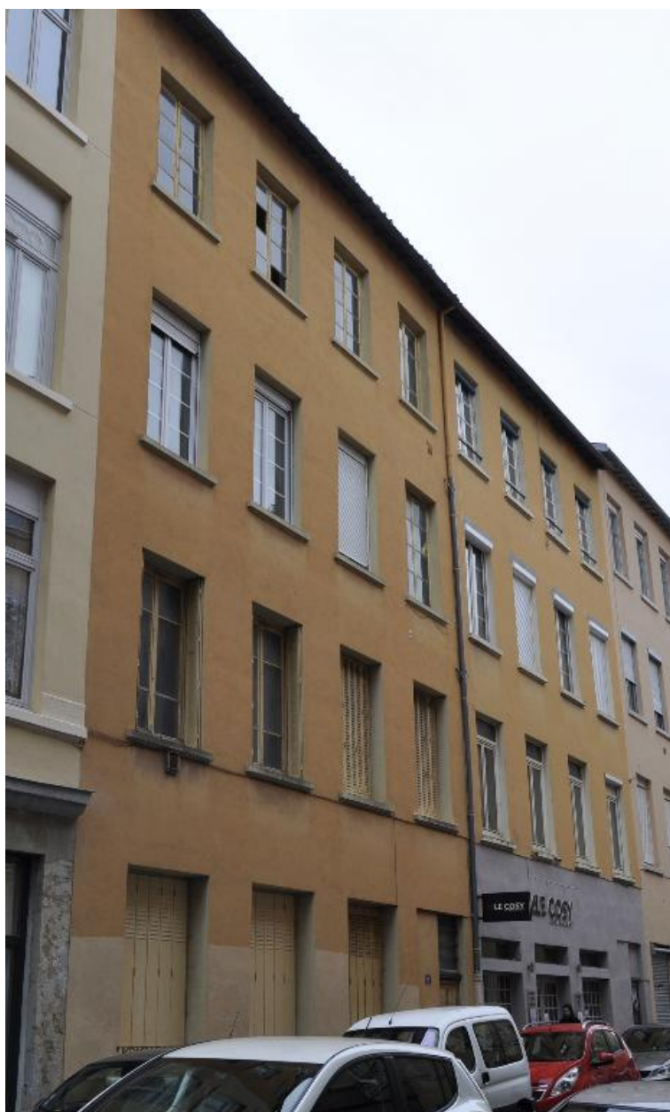
Vue générale de la façade
