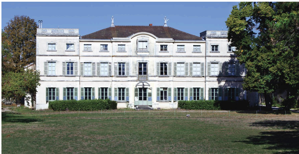
Façade est, vue générale
