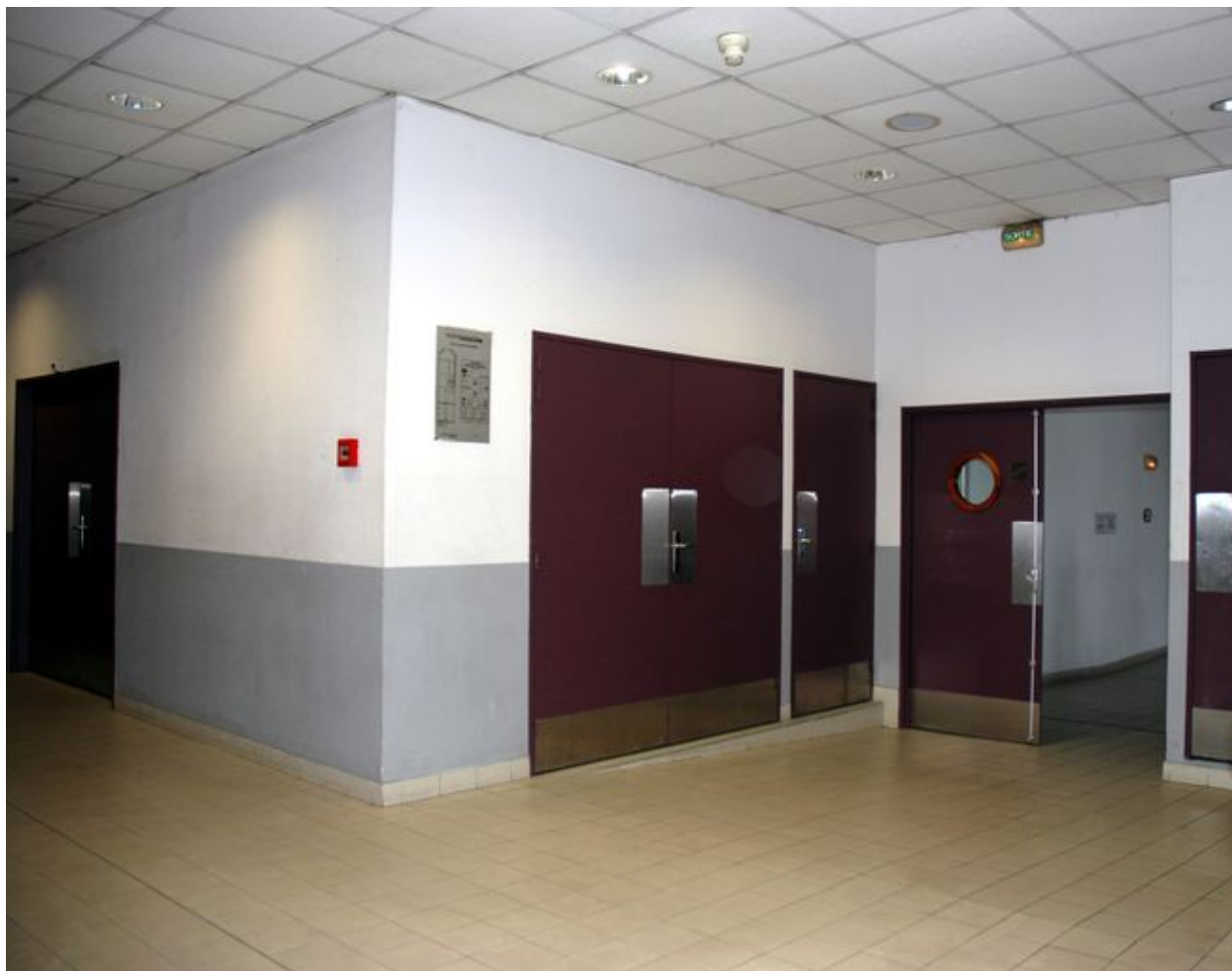
Bâtiment B : couloir
