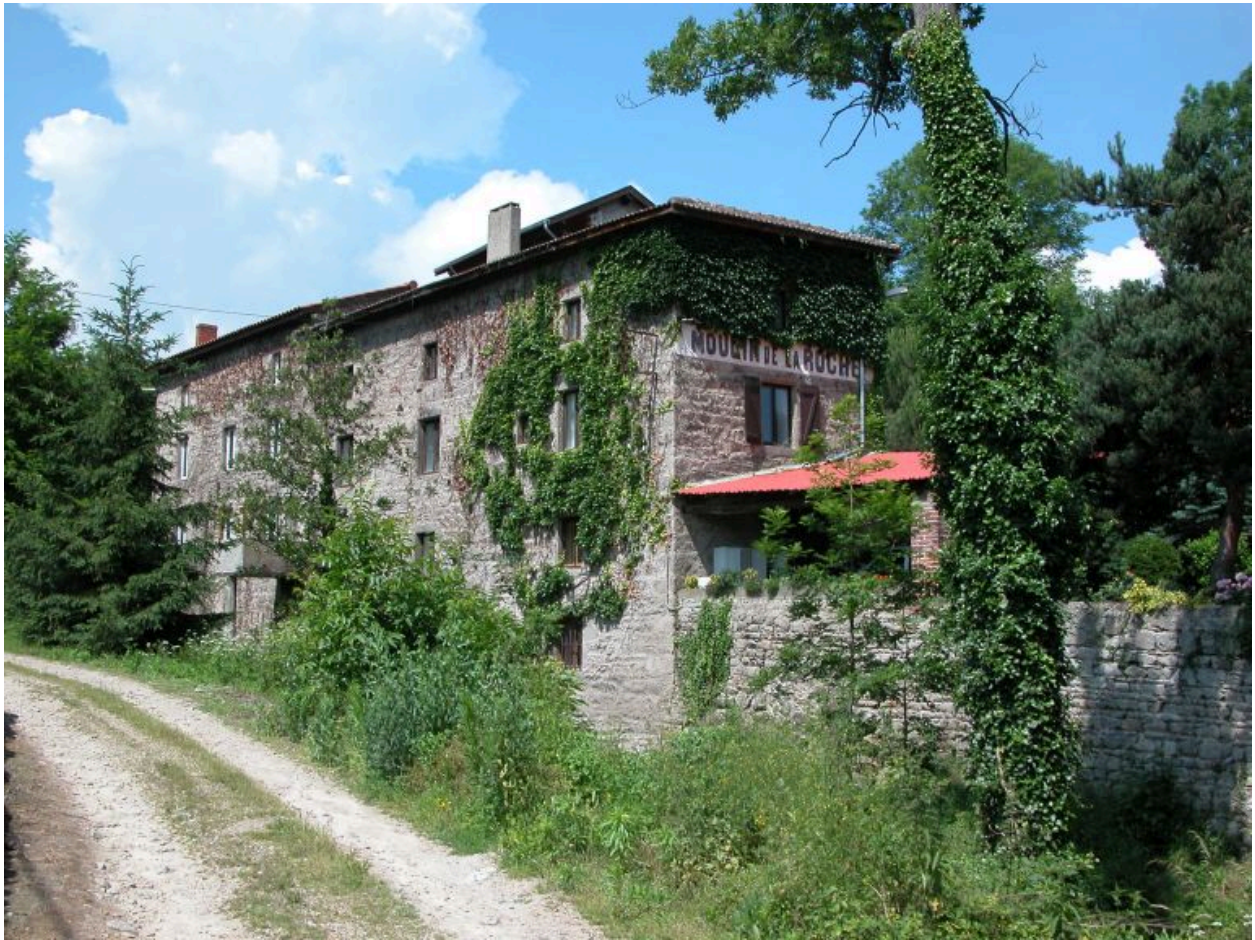
Vue d'ensemble de la façade sud-est du moulin.
