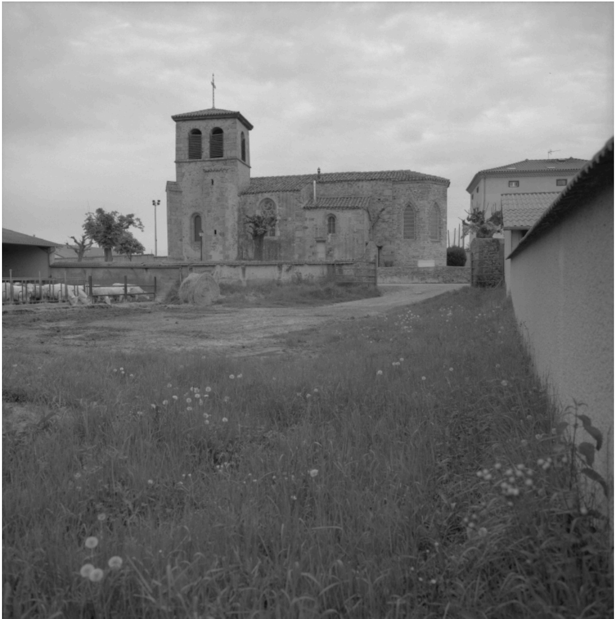
Vue générale de l'élévation sud.
