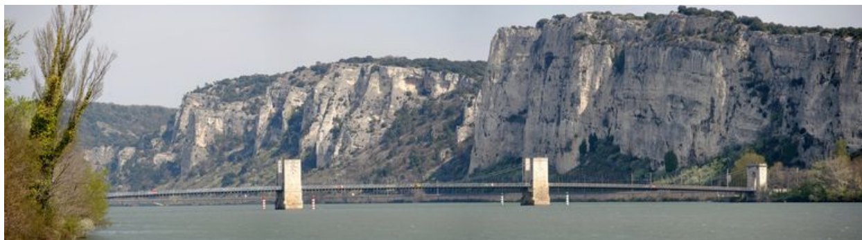
Vue panoramique, côté aval (sud)
