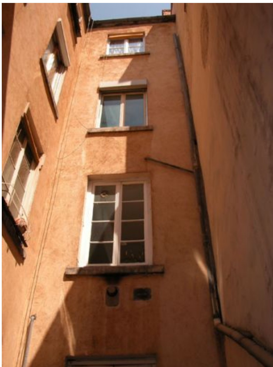
Bâtiment 2, élévation est sur la cour II
