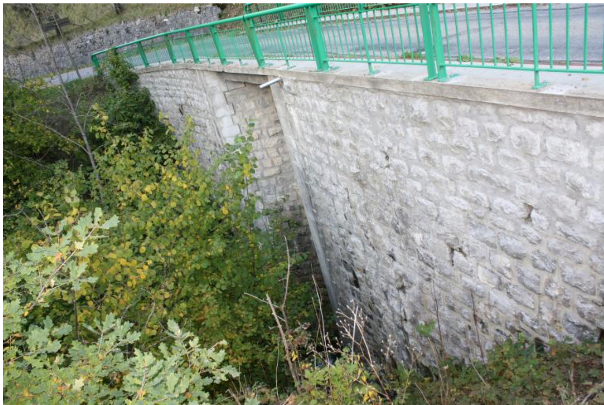
Pont de l'Abbaye, face aval
