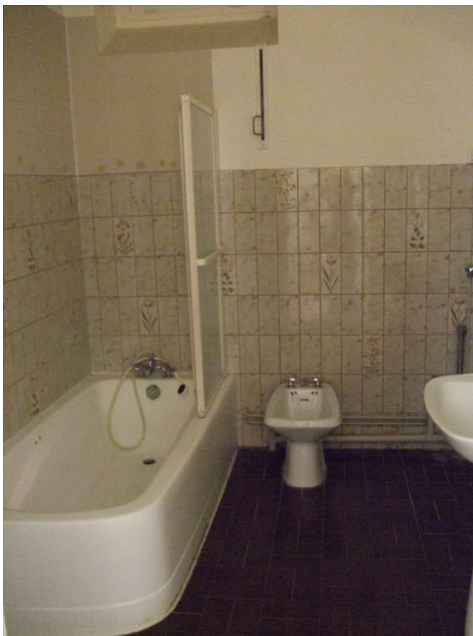
Salle de bains appartement de fonction du 1er étage
