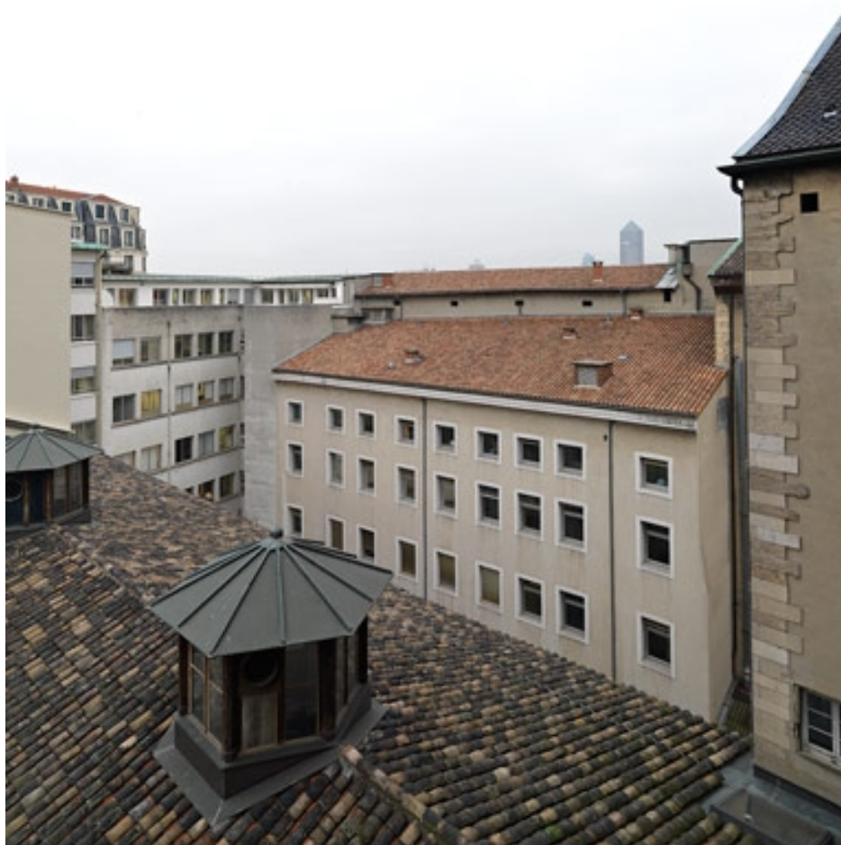
Bâtiment N. Elévation ouest
