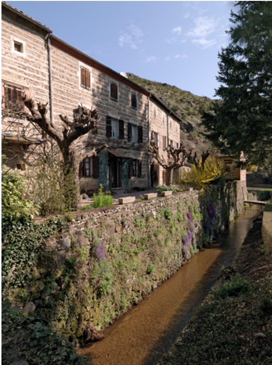
Vue depuis le sud-est, avec le passage du bief.
