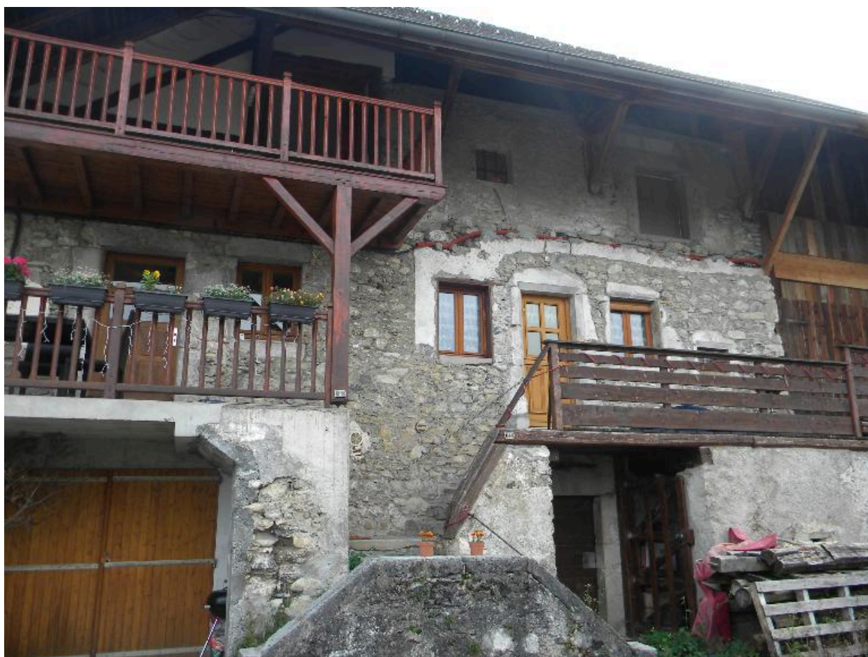
Détail de la façade ouest avec la double volée d'escalier
