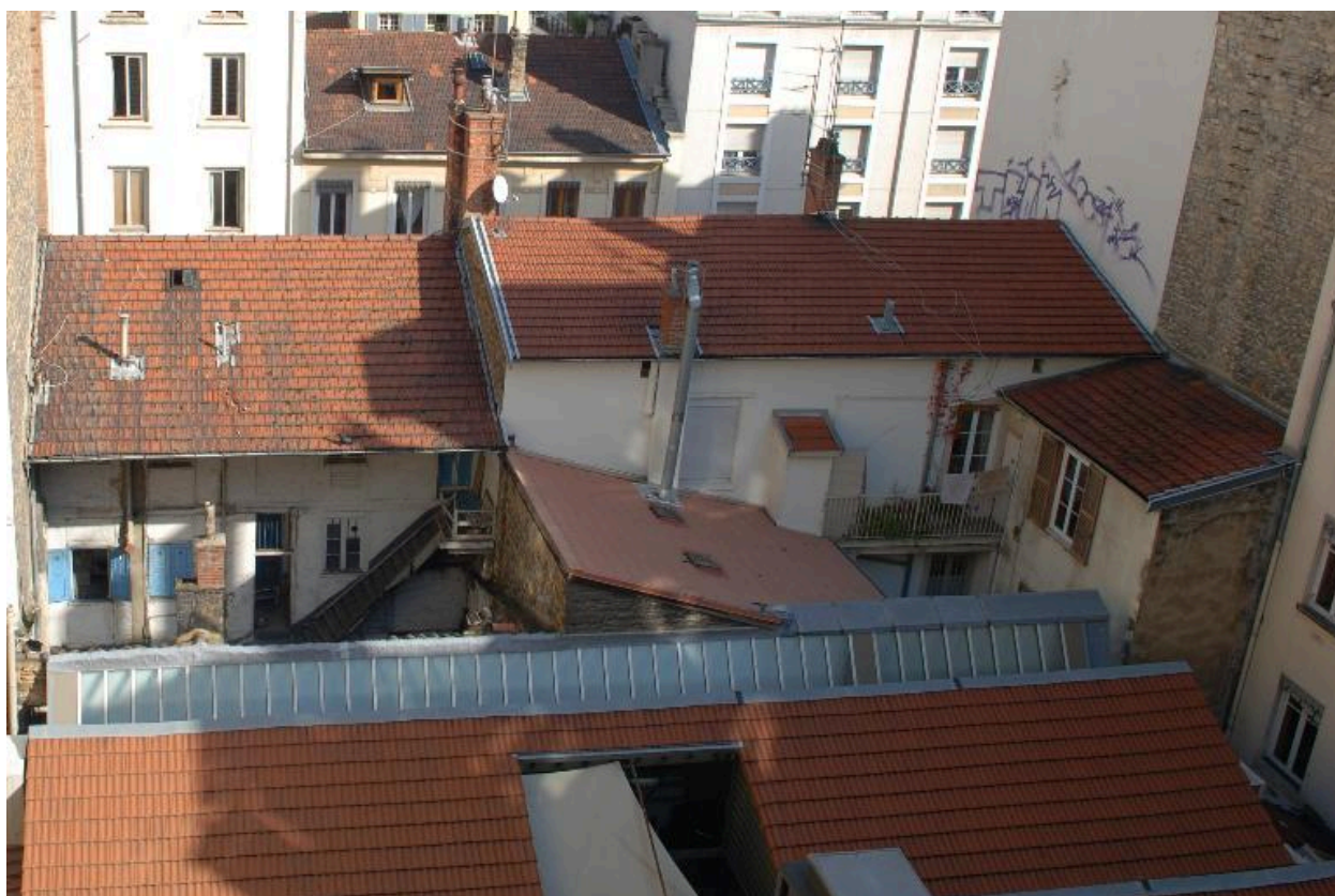
Vue générale des bâtiments sur cour
