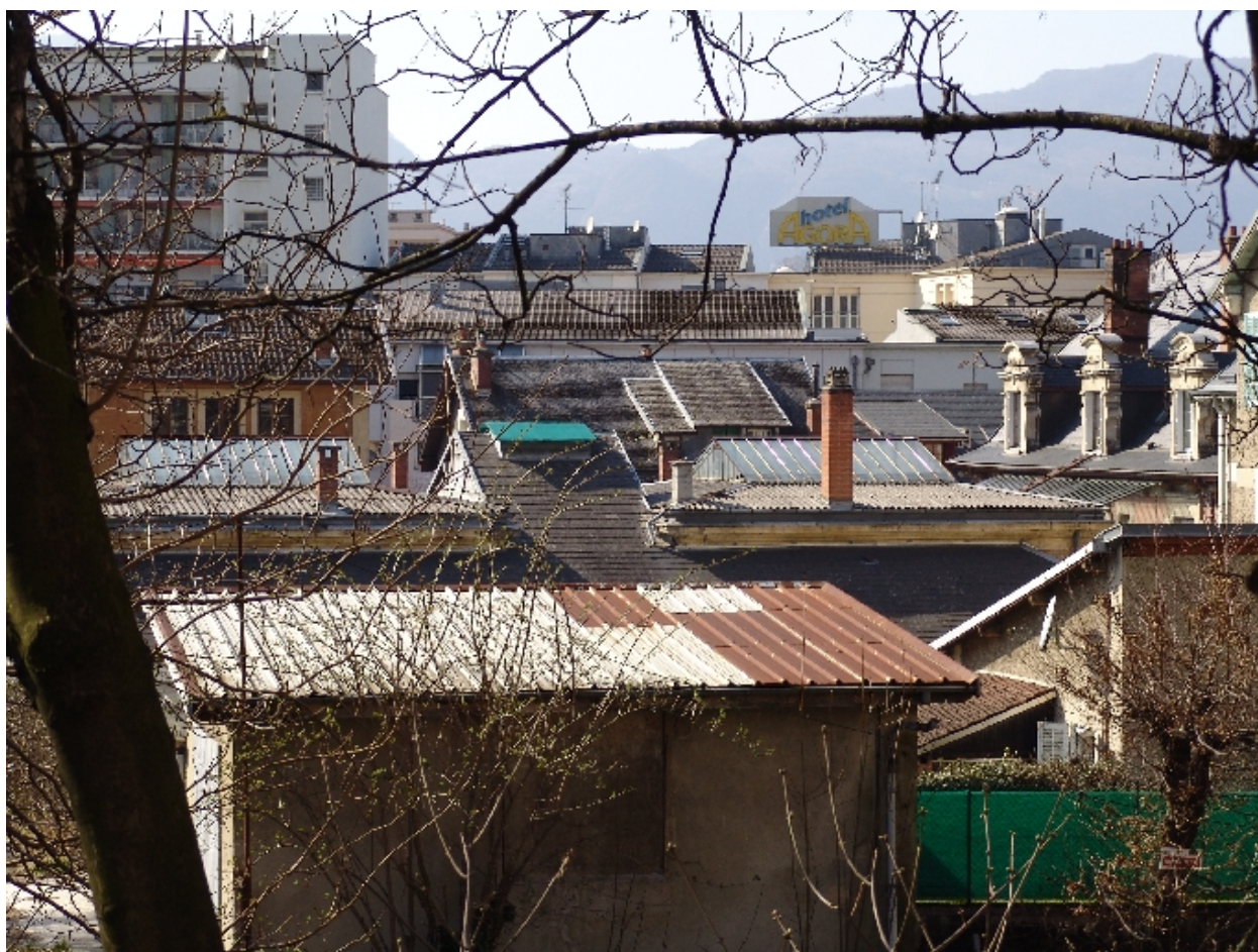
Toiture du bâtiment de mécanothérapie
