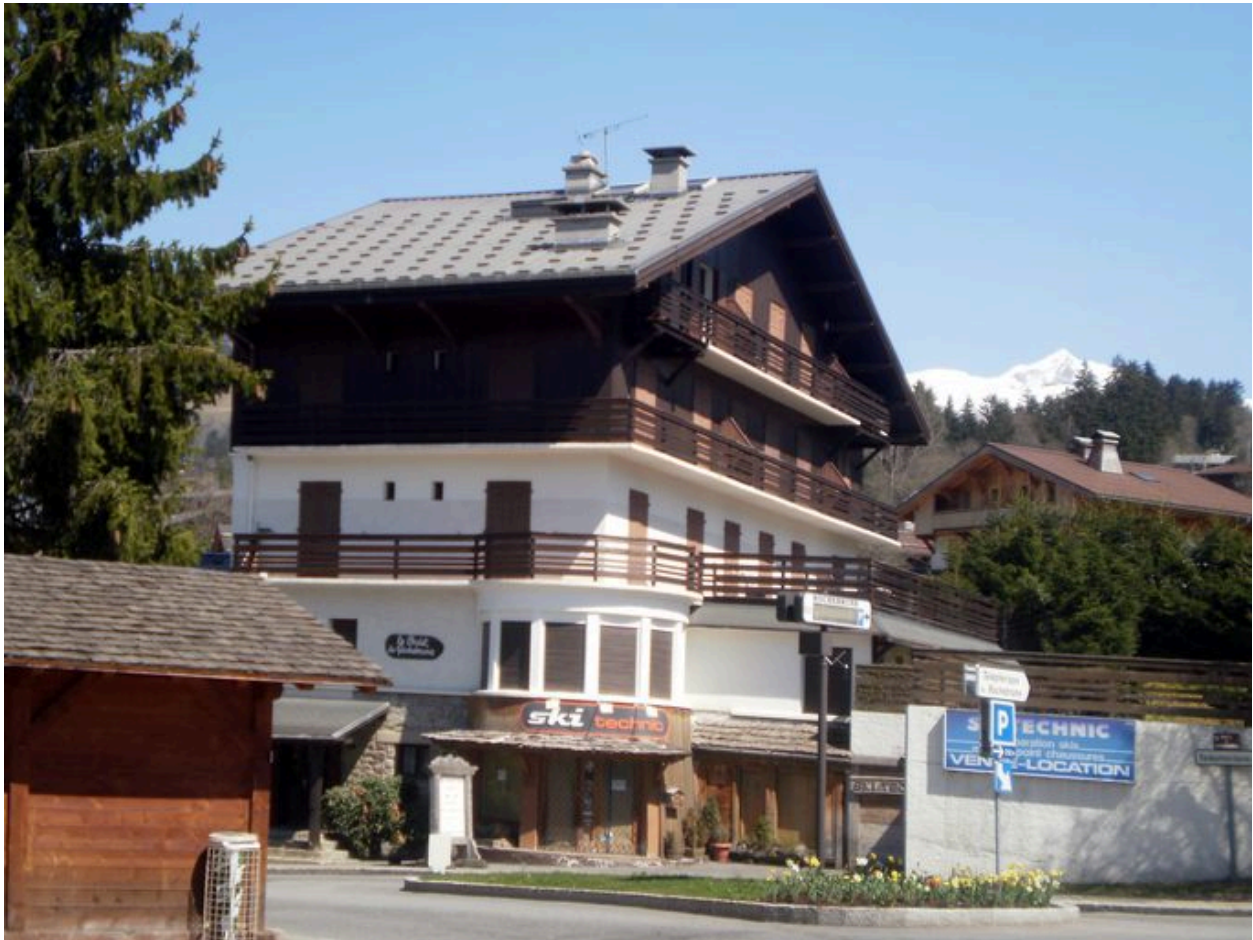
Ancienne Auberge ensoleillée, 513 route de Rochebrune
