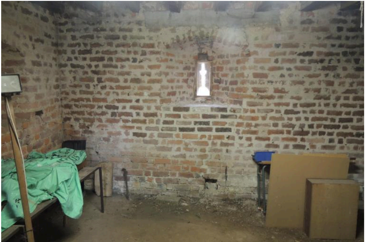
Tour sud-ouest : intérieur, rez-de-chaussée.
