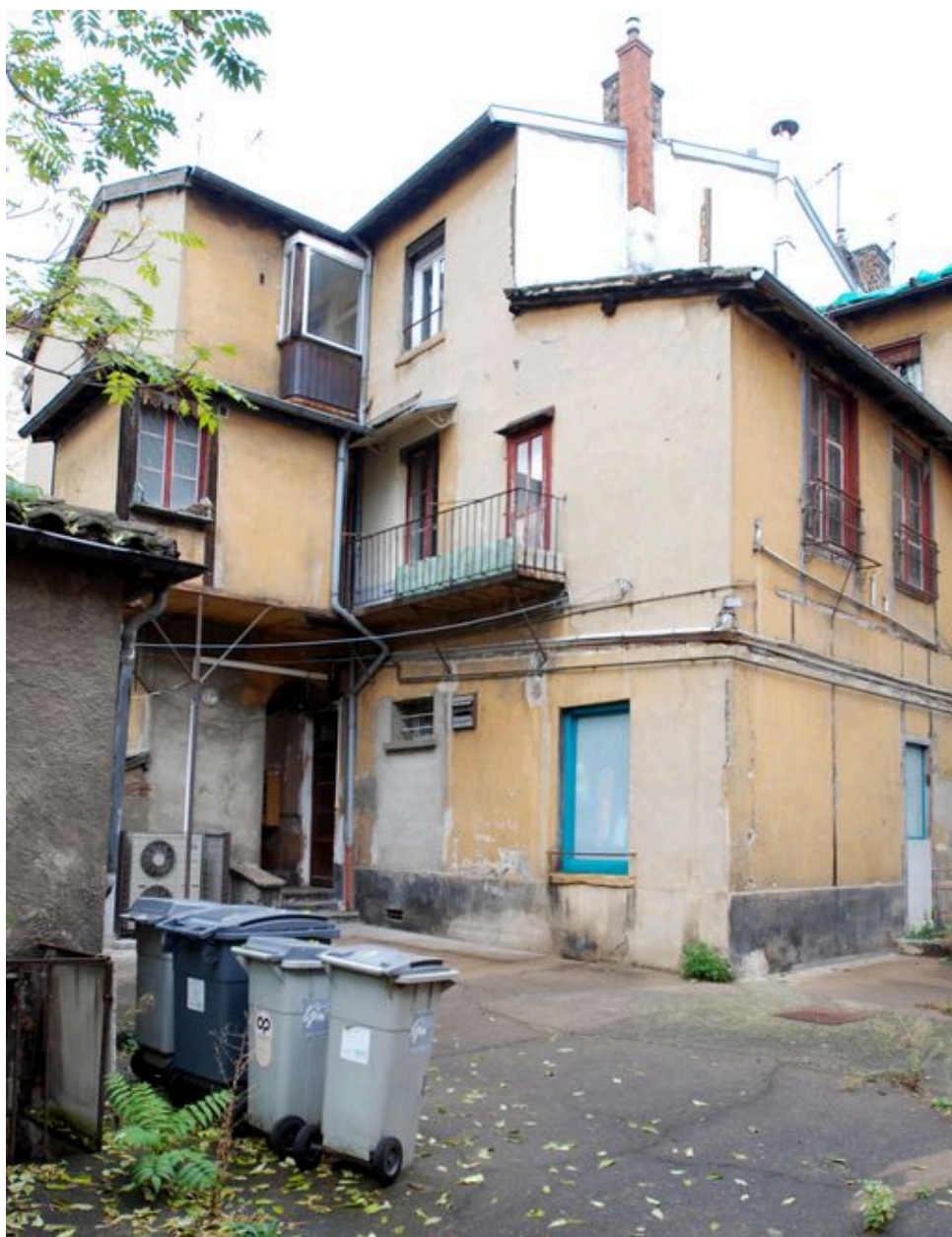
Elévation postérieure, depuis le sud-est
