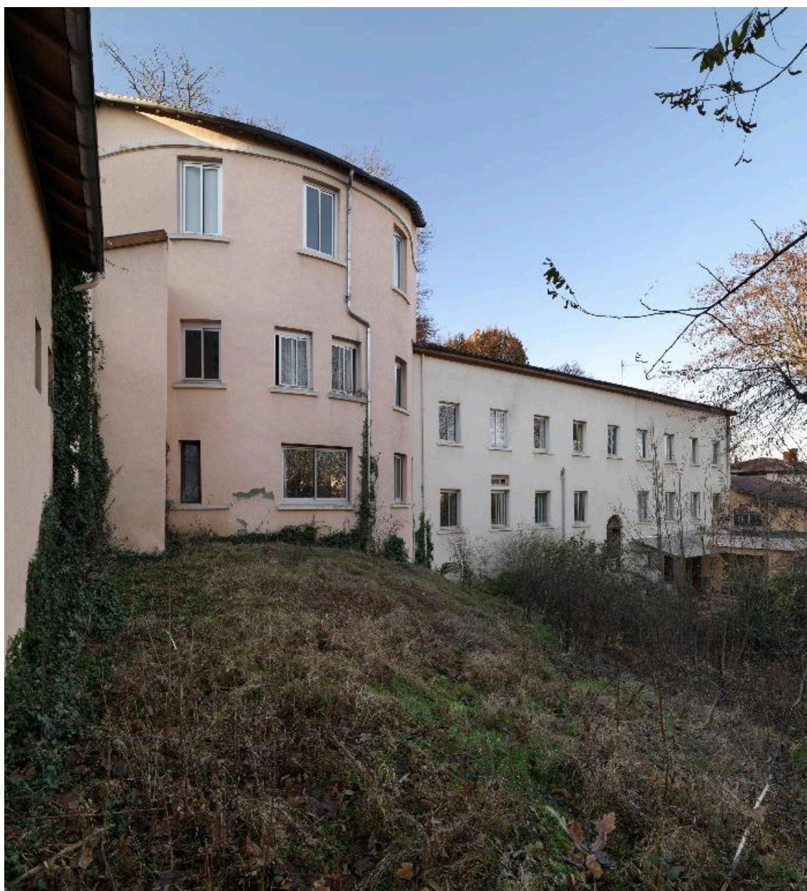
Bâtiment central, élévation orientale, corps de liaison au premier plan
