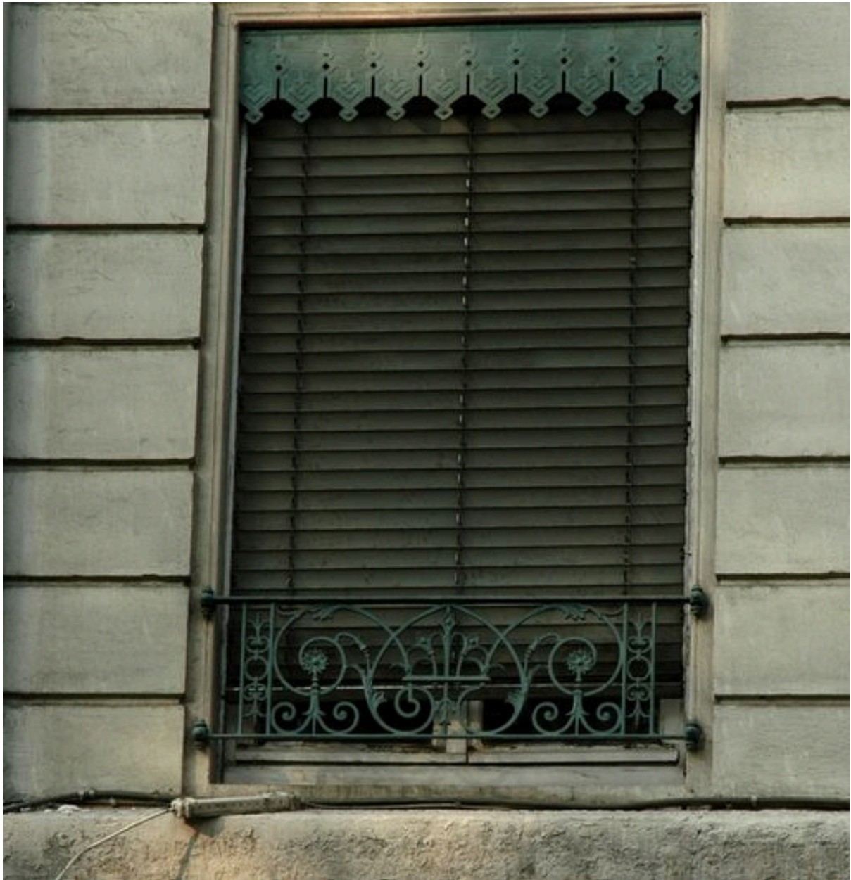
Détail d'une fenêtre, rue de Créqui
