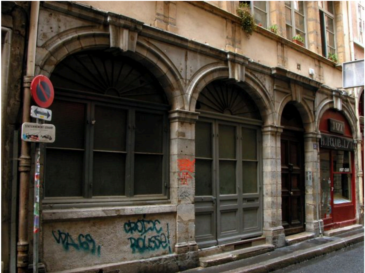
Façade sur rue, rez-de-chaussée
