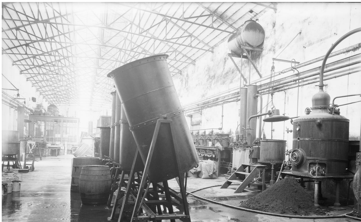
Vue d'intérieur Rhône-Poulenc usine 1910 (BML : P0546 S 1692)
