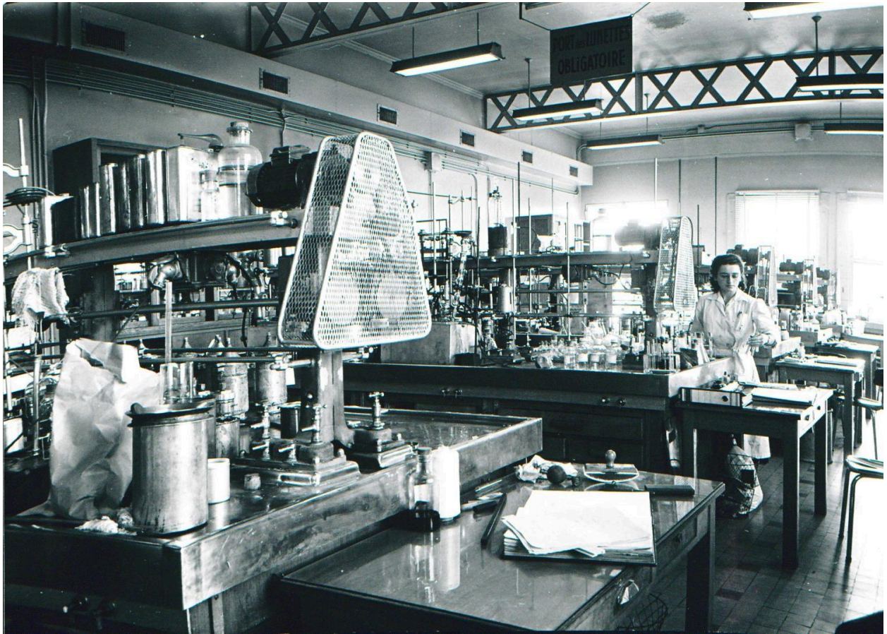
Vue d'intérieur filatures de Vaise 1960 laboratoire (ADRhône : 1ETP5823)
