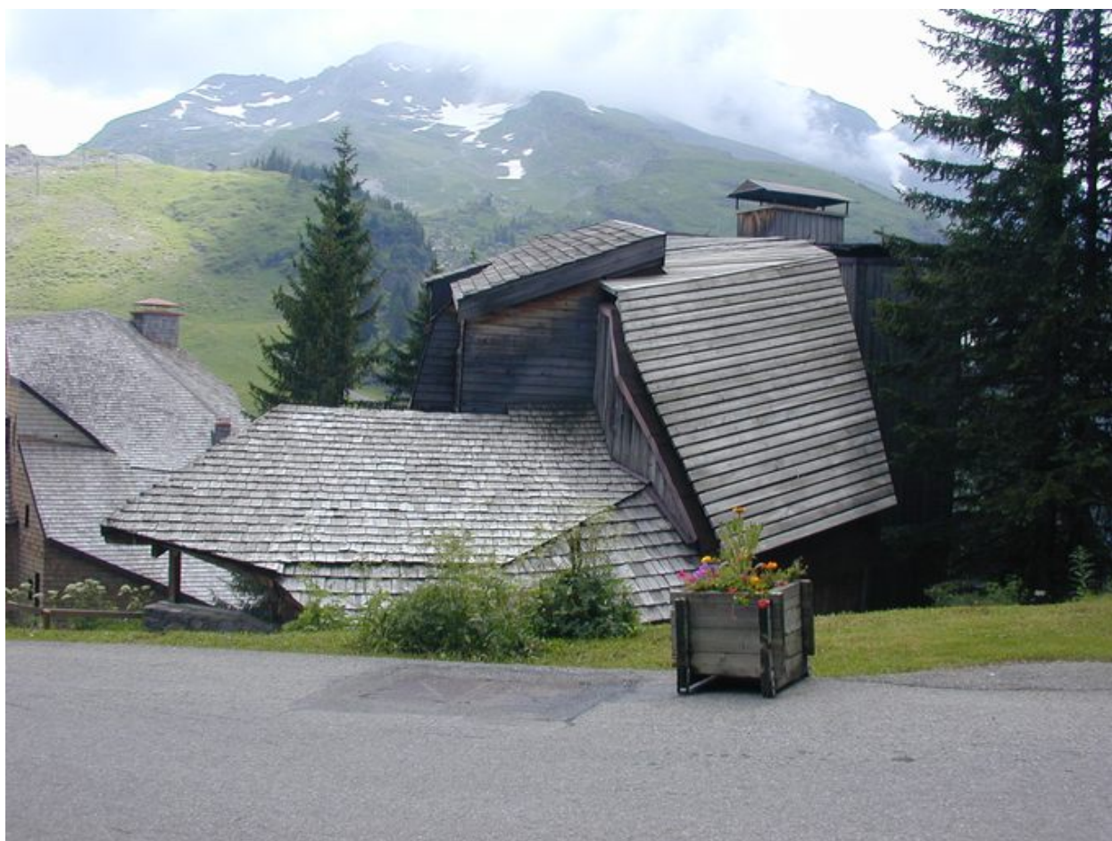
Vue d'ensemble des toitures depuis le chemin à l'amont
