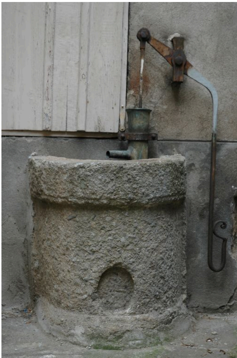
Puits avec cuve semi-circulaire en granite, adossé contre l'élévation postérieure sur cour.
