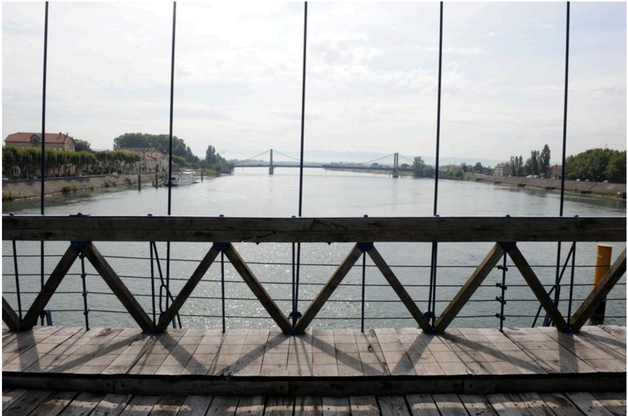
Travée gauche, face aval, vue partielle : parapet et trottoir (depuis la chaussée) ; le pont Toursier en arrière-plan
