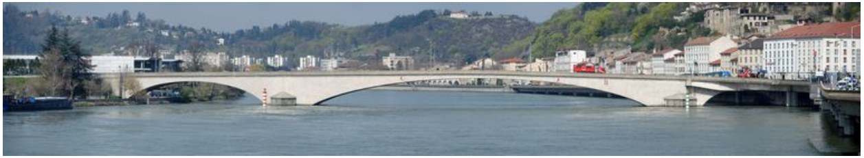
Vue panoramique, côté aval
