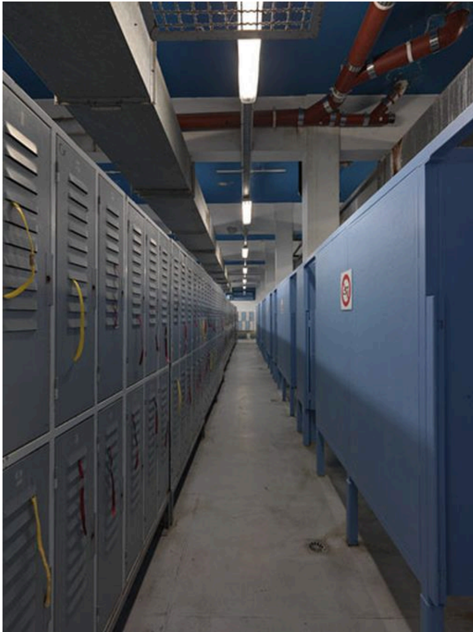
Vue des vestiaires femmes au nord (état en juin 2012).
