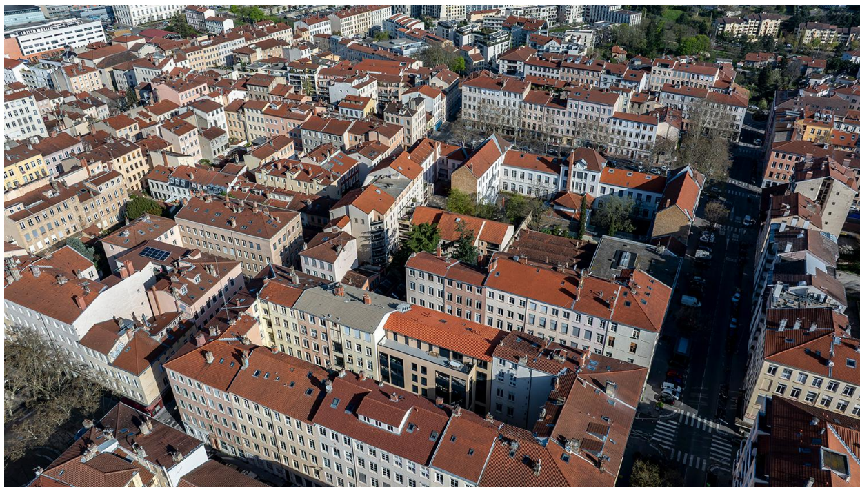
Vue d'ensemble secteur des immeubles-ateliers (vue drone)
