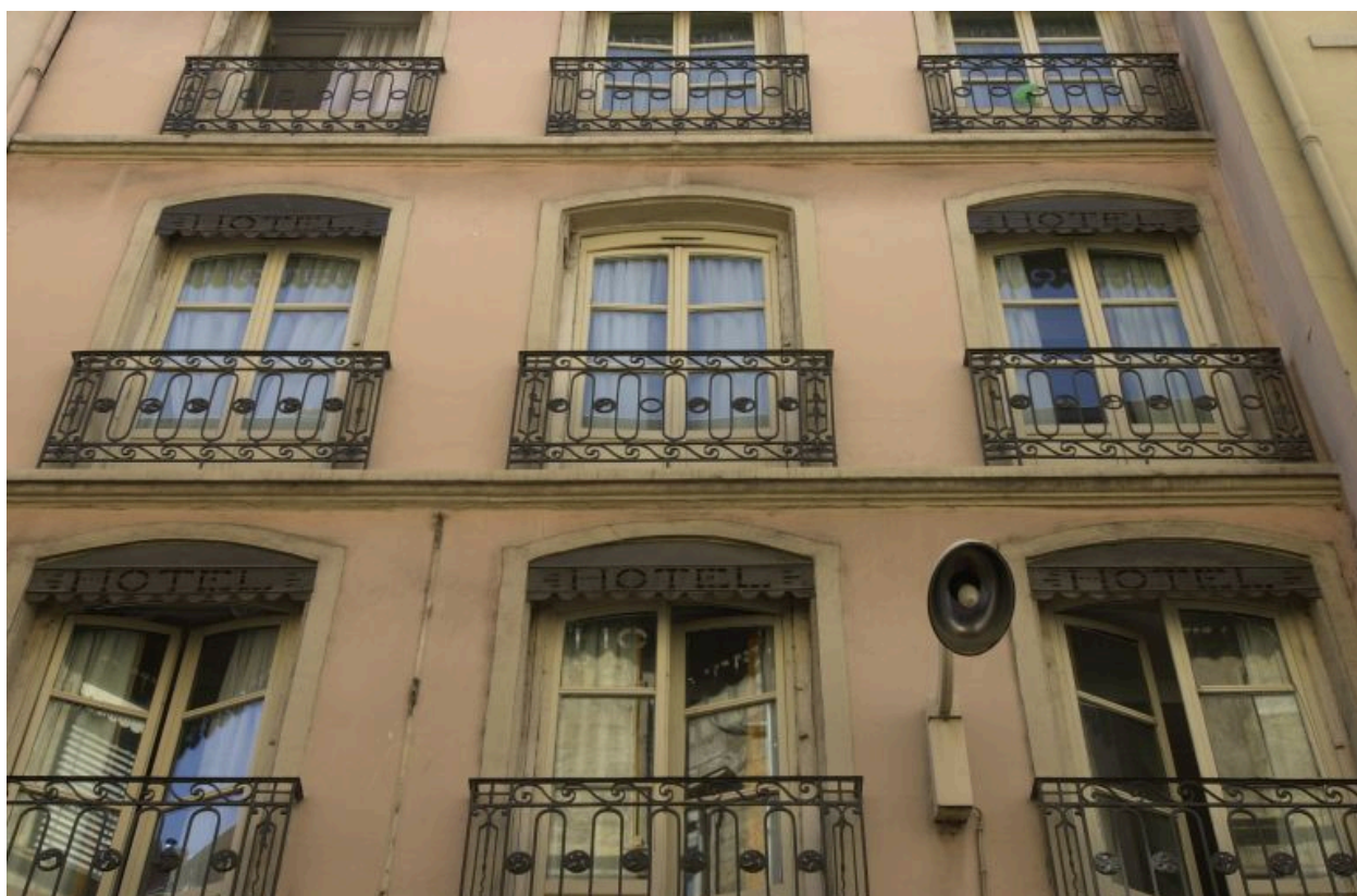
Façade, vue des fenêtres du troisième niveau
