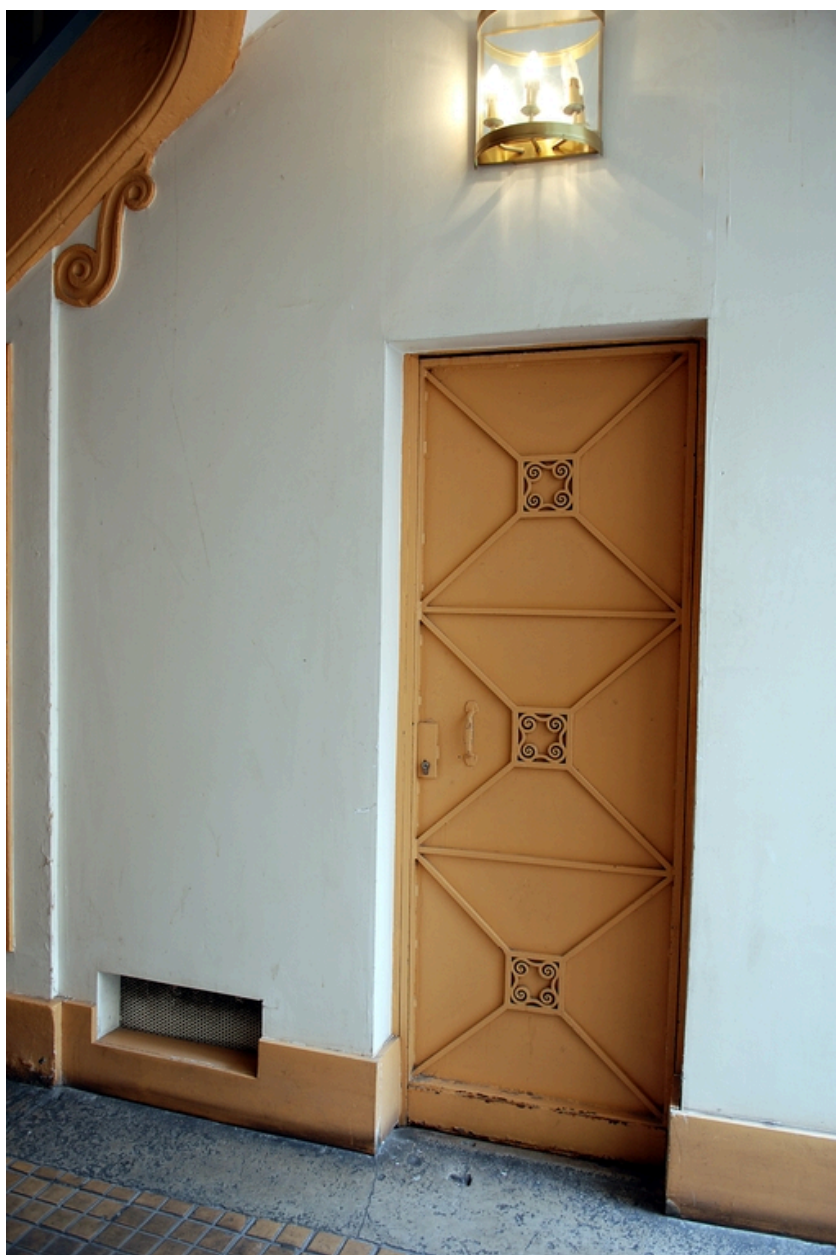
Le passage cocher : porte métallique
