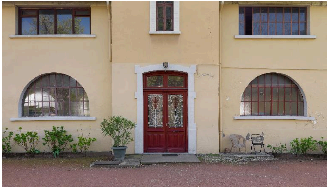
Château d'eau : détail de l'entrée
